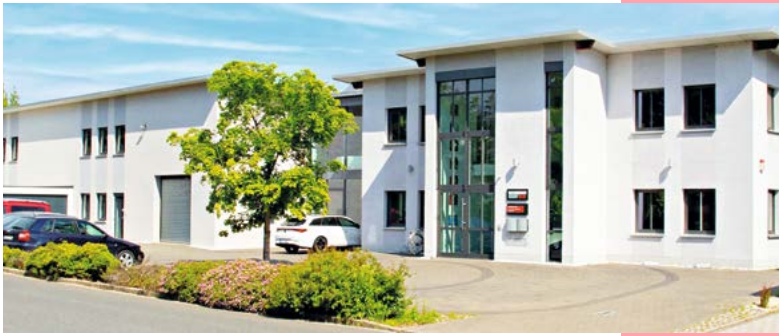
Heimat der Kaldenbach GmbH: Das Firmengebäude im fränkischen Hersbruck.
