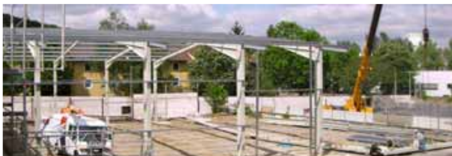
Baubeginn auf dem Sprintis-Grundstück.
