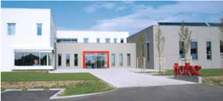
Das zertifizierte GreenBuilding in Marchtrenk, Oberösterreich.
