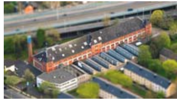
Das schöne historische Hauptgebäude steht noch. Drinnen und drumherum arbeitet das Unternehmen indes nach den modernsten Standards.
